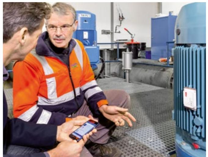
pen, um ein Verstopfen oder andere Probleme, beispielsweise bei Abwasserpumpen, zu verhindern. Bisher mussten die Pumpen mitunter mehrmals pro Woche zeitraubend auf Verdacht überprüft werden. Jetzt werden die Daten direkt in die ABB Ability Cloud übertragen; die Pumpenbetreiber können bestimmte Daten über eine App auf ihrem Smartphone ablesen. ABB und spezialisierte Partnerunternehmen führen in der Cloud zusätzliche Analysen durch, um für den weiteren Betrieb relevante Tendenzen zu erkennen.
