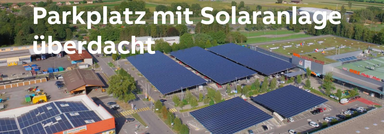
Mit dem «Solarparkplatz» deckt die Migros im Einkaufszentrum Chablais rund die Hälfte ihres Stromverbrauchs. Ein schweizweit einzigartiger Wechselrichter wandelt den Gleichstrom aus den PV-Modulen in Wechselstrom um.
