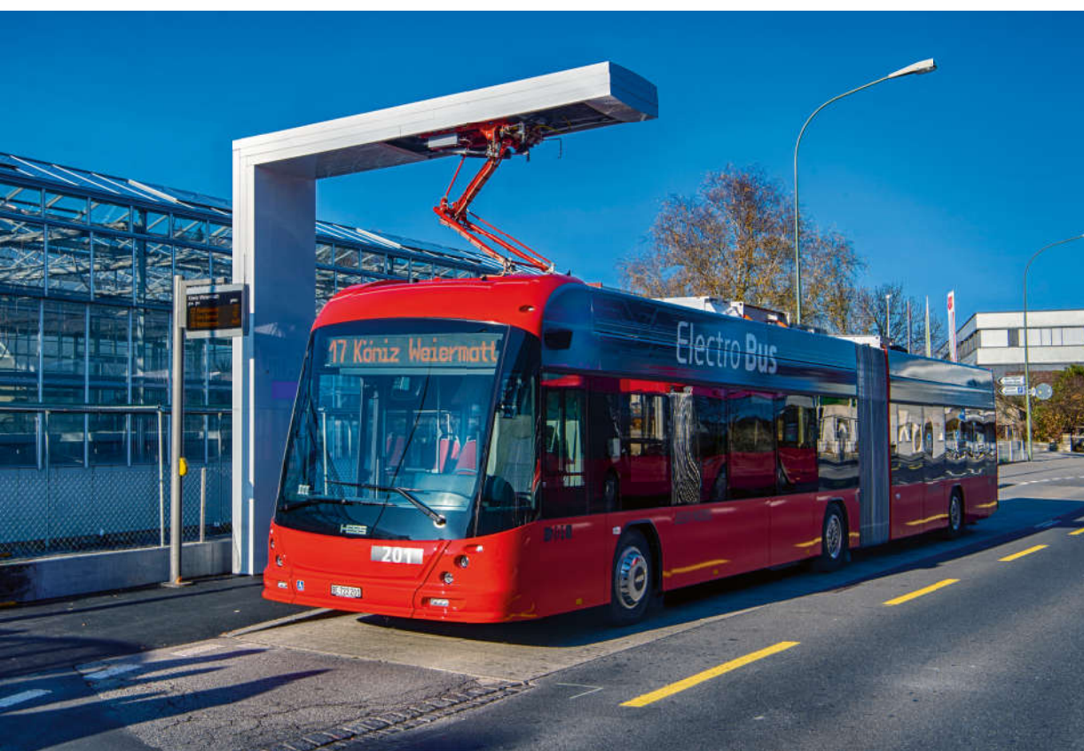
Die Elektrobusse der Linie 17 in Bern tanken an der Endhaltestelle Energie an einer ABB-Schnellladestation. Der Vorgang läuft über einen Stromabnehmer, der sich von der Station herabsenkt.
