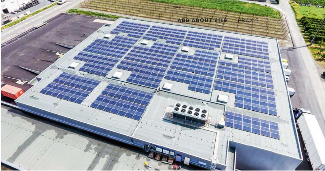
PV-Anlage umfasst rund 940 Solarpanels. Die drei ABB-Wechselrichter (weiss) sind an der Wand am unteren Bildrand zu sehen.
