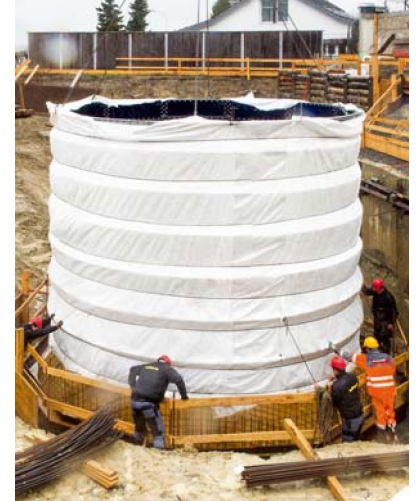
— Das erste energieautarke Mehrfamilienhaus der Welt in Brütten ist durch die kompakte Gebäudeform, ansprechende Wohnungen und einen Wassertankspeicher mit 250 000 l als Heizungsvorsorge charakterisiert.
