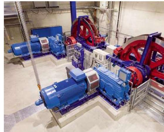
tragende Stütze gibt, ist auch das freie Spannungsfeld mit 3213 m das längste der Welt. Gebaut hat die Pendelbahn das Schweizer Unternehmen Garaventa AG, Teil der Doppelmayr/Garaventa-Gruppe, Weltmarktführer im Seilbahnbau. Bei einer Pendelbahn laufen zwei Gondeln gegenläufig über eine Tragseilkonstruktion, die sie in der Luft hält. Von einem Elektromotor bewegte Zugseile sorgen für den Antrieb.
