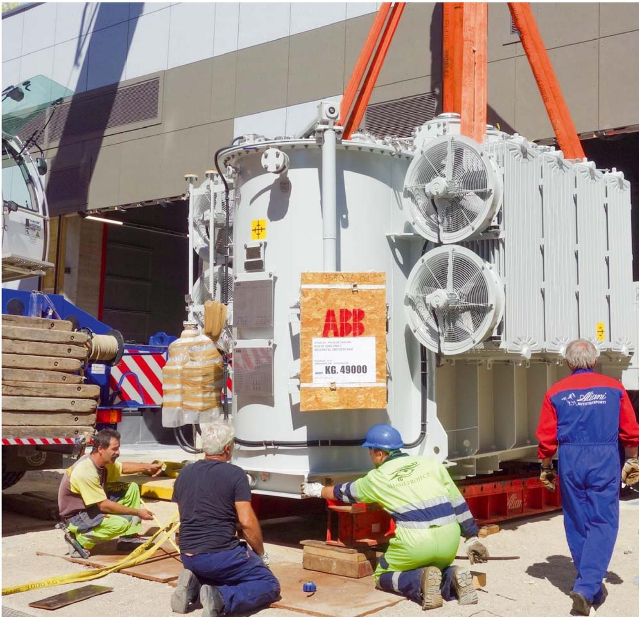
Die Anlieferung der rund 50 t schweren Transformatoren bei den engen Platzverhältnissen erforderte viel Fingerspitzengefühl.
