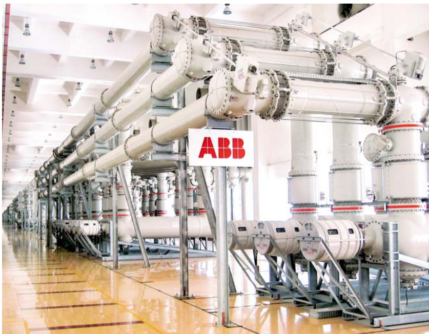
Die weltgrösste mit \text{SF}_6 isolierte GIS an der Drei-Schluchten-Talsperre des Jangtsekiangs in China ist auf 550 kV ausgelegt.
