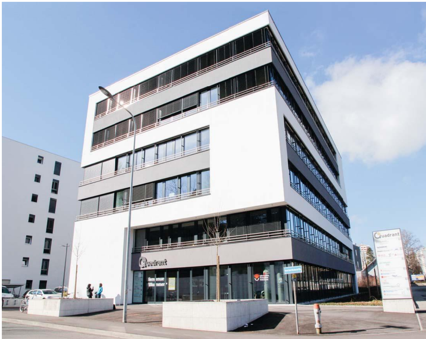
Im Quadrant in Freiburg wurde mit KNX-Geräten von ABB eine energieeffiziente Gebäudeautomationslösung realisiert.
