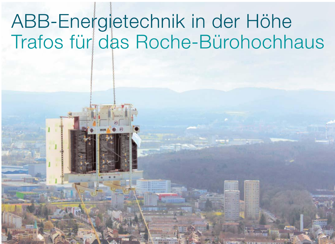
Anlieferung eines Transformators in Etage 41 des Roche Gebäudes Bau 1 vor dem Panorama Basels.
