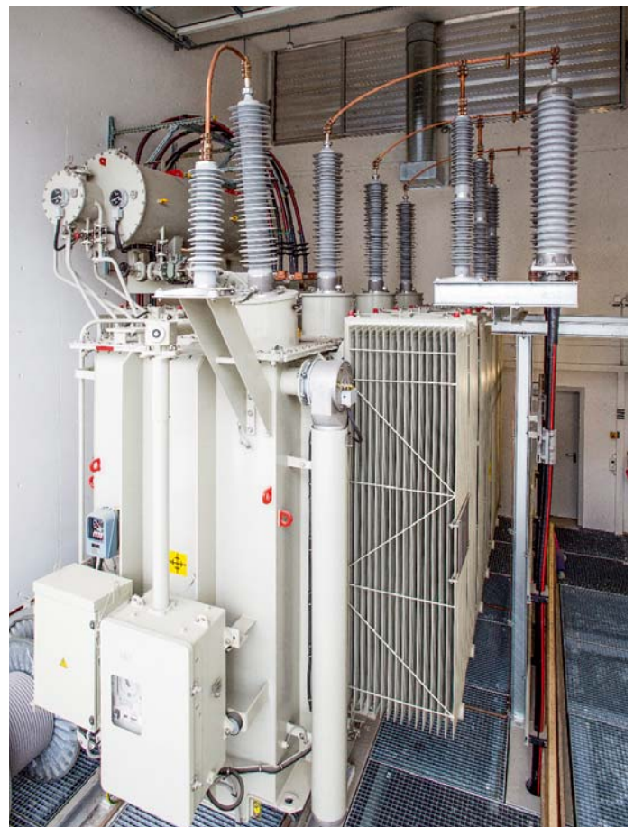
Le transformateur de 40 MVA fourni par ABB.
