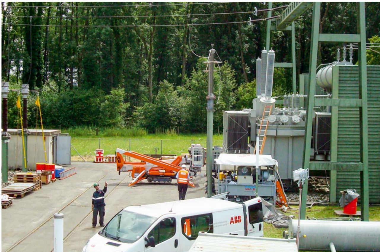
Le transformateur de remplacement peu avant sa mise en service.
