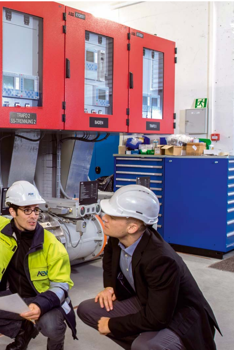
Thomas Doll et Daniel Fondado devant l'installation de distribution isolée au gaz de 110 kV, avec Raphael Sauter, ingénieur des ventes Produits et systèmes de haute tension chez ABB Suisse (de g. à dr.).
