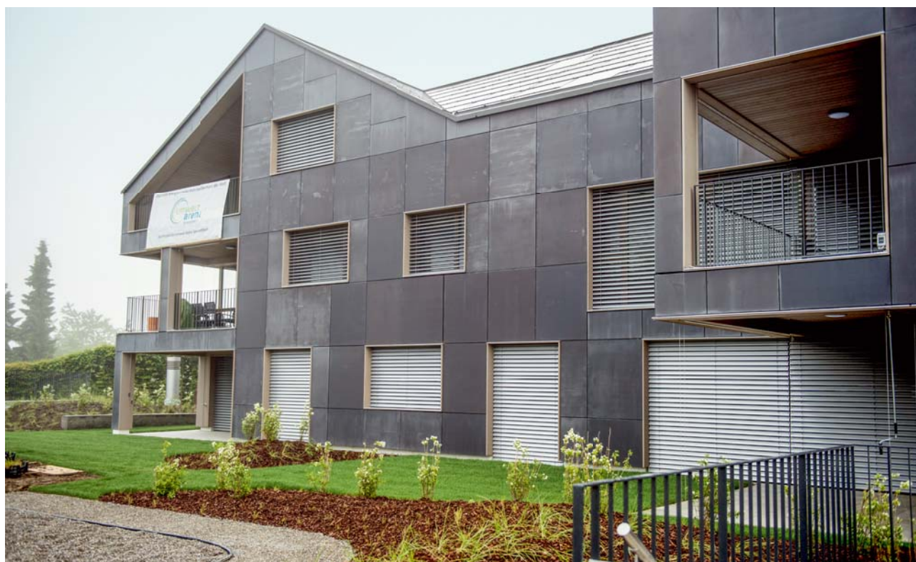
Le premier immeuble énergétiquement autonome du monde à Brütten – un projet de l'Umwelt Arena.
