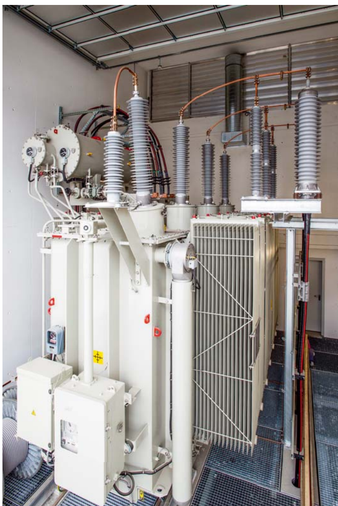
Der von ABB gelieferte 40-MVA-Transformator.
