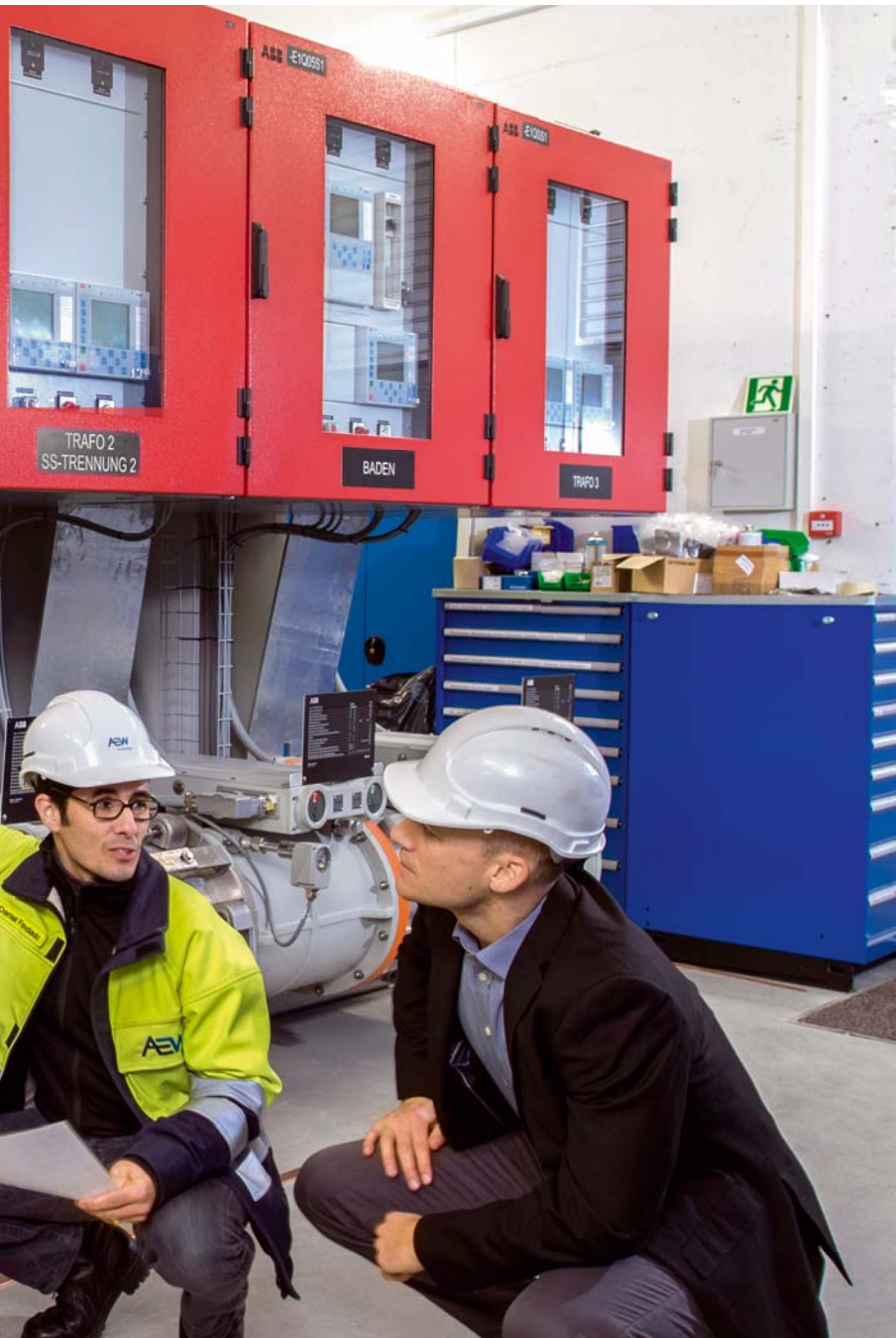
Thomas Doll und Daniel Fondado vor der gasisolierten 110-kV-Schaltanlage, zusammen mit Raphael Sauter, Verkaufsingenieur Hochspannungsprodukte und Systeme bei ABB Schweiz (v. l. n. r.).
