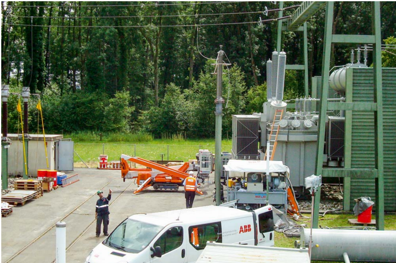
Der Ersatztransformator kurz vor seiner Inbetriebnahme.
