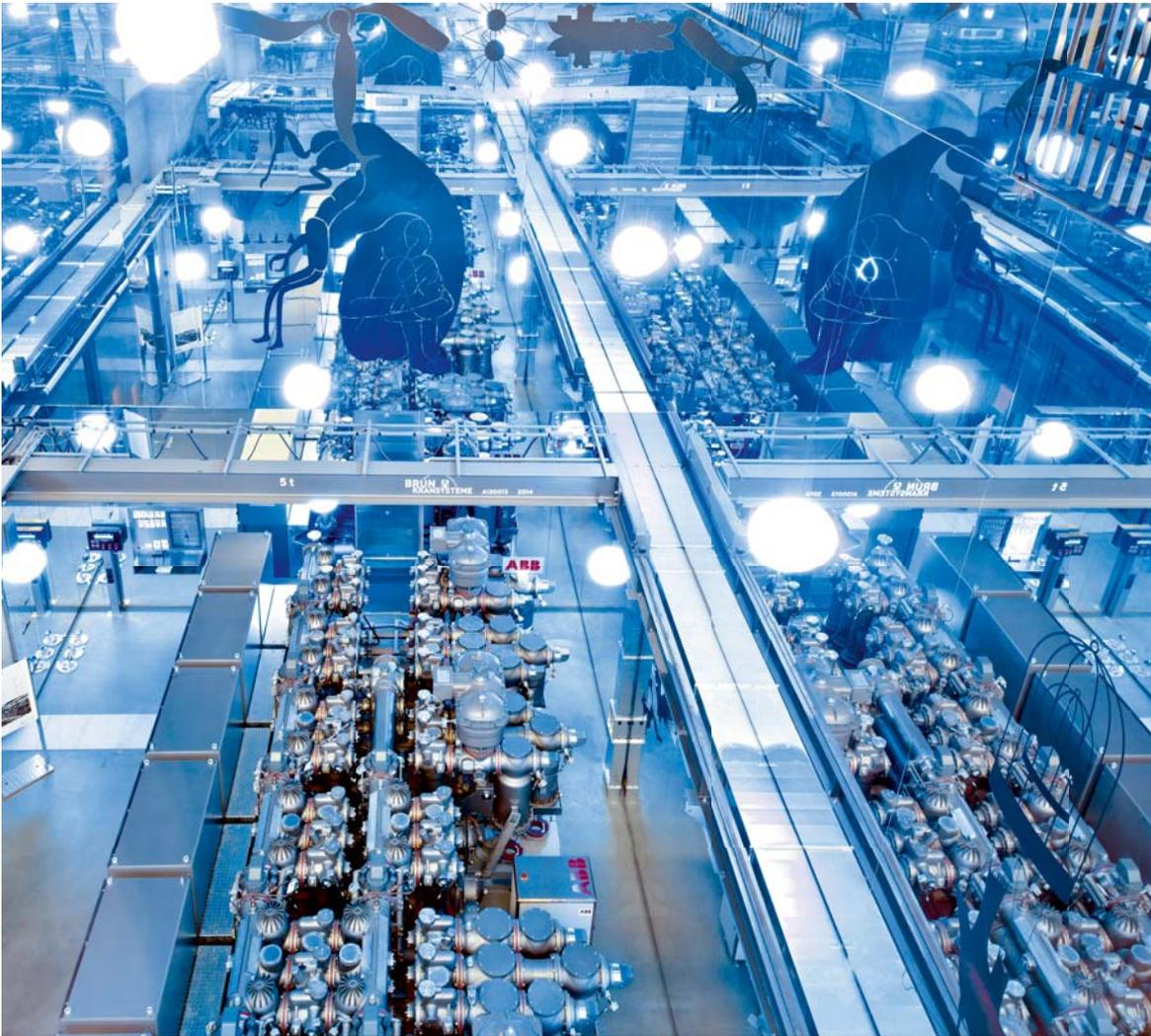
Vue de l'extérieur sur l'installation de distribution haute tension (170 kV) d'ABB dans la sous-station Oerlikon d'ewz.
