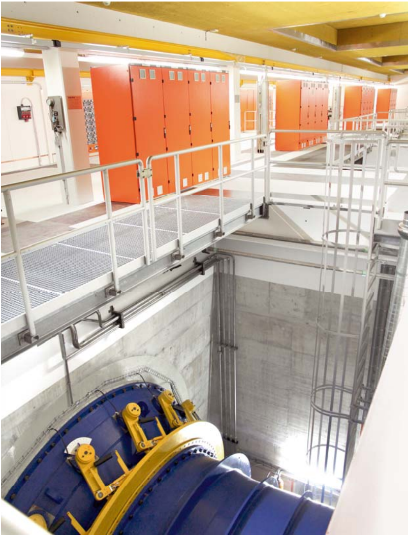
Einblick in das Innere des Axpo-Flusskraftwerks in Aarau.
