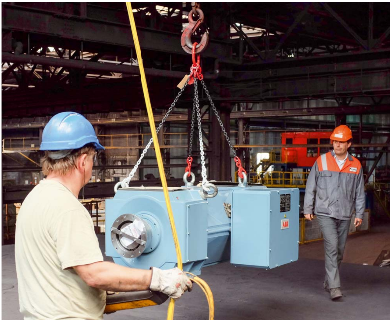
Anlieferung des ersten neuen DC-Motors für die Vorstrasse des Walzwerks in Gerlafingen.
