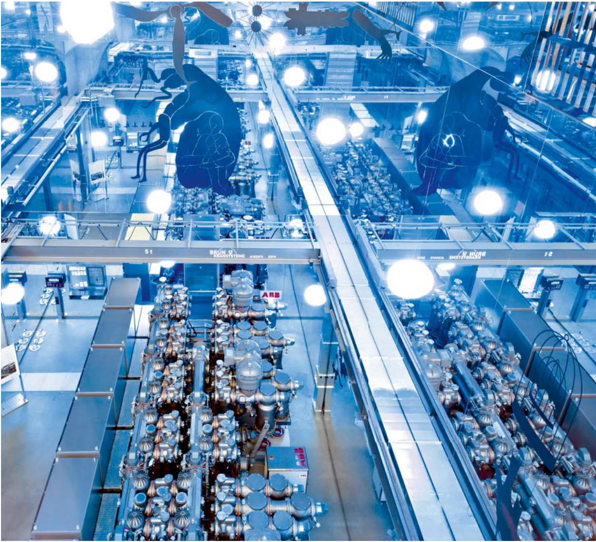
Blick von aussen auf die Hochspannungs-Schaltanlage (170 kV) von ABB im Unterwerk Oerlikon von ewz.
