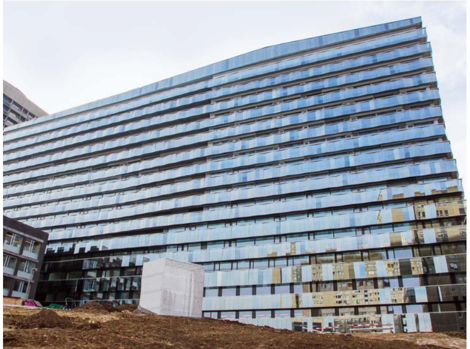
Das eindrückliche neue Bettenhaus des Zürcher Stadtsitals Triemli.
