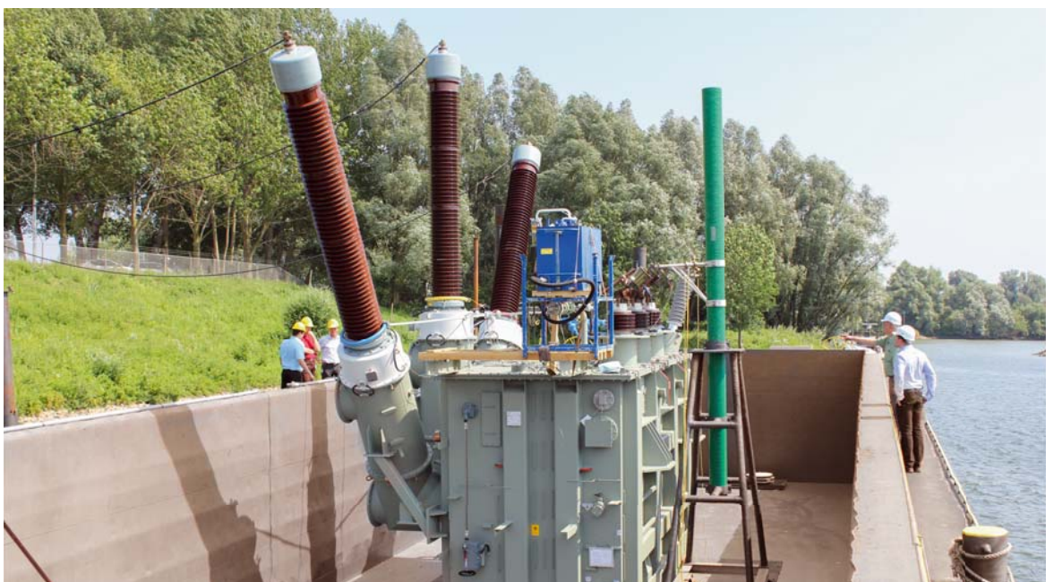
Der riesige Transformator wurde auf dem Rhein ins Testlabor transportiert.
