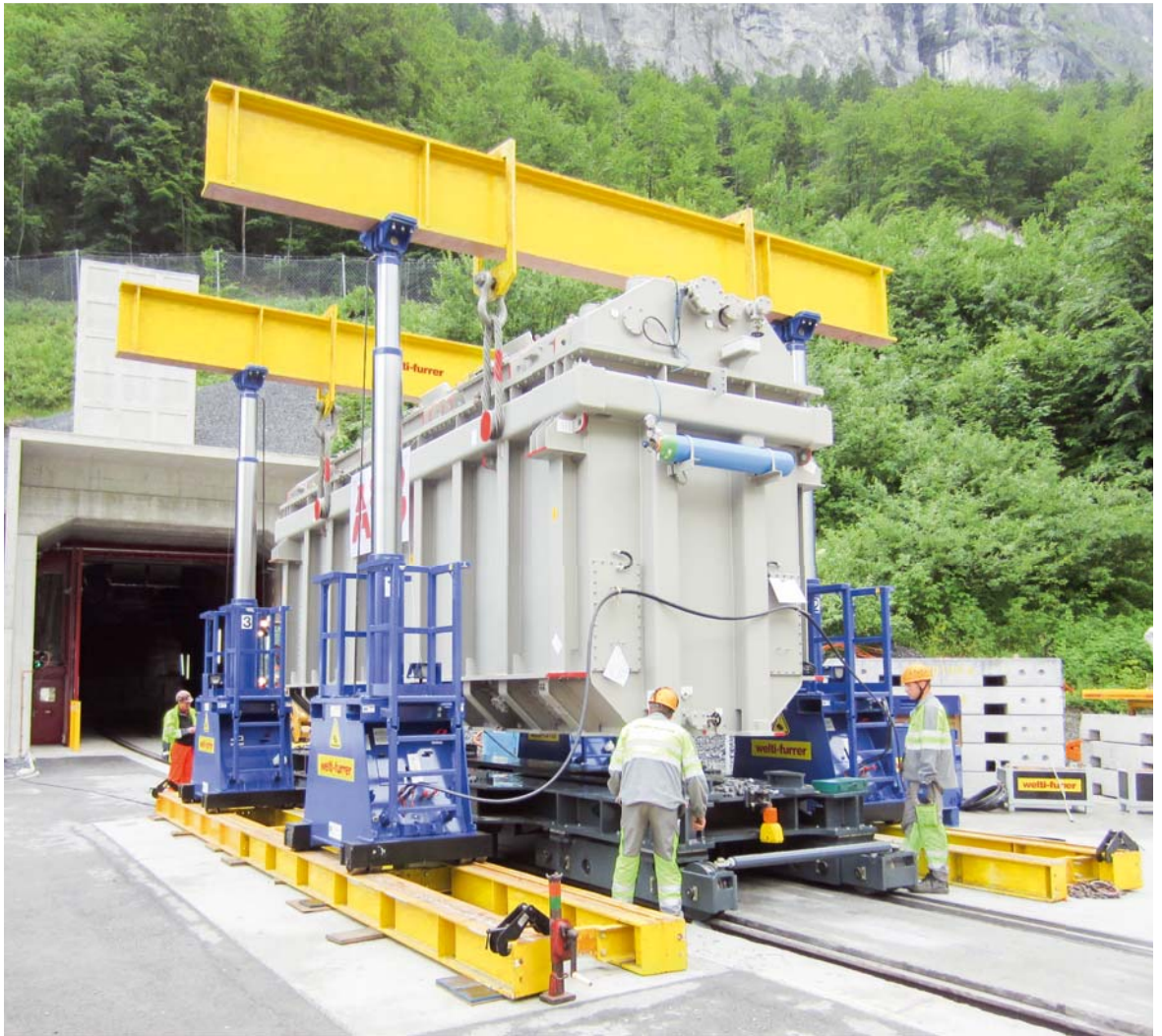
Ein Transformator vor der letzten Etappe der langen Reise am Eingang zur Standseilbahn.
