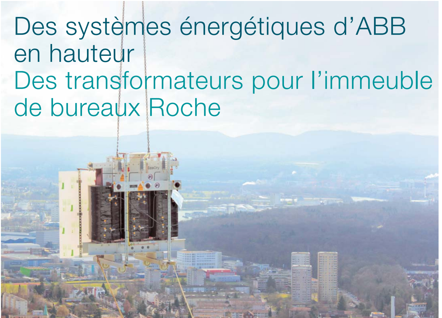
Livraison d'un transformateur au 41 e étage du Bloc 1 du bâtiment Roche face au panorama de Bâle.
