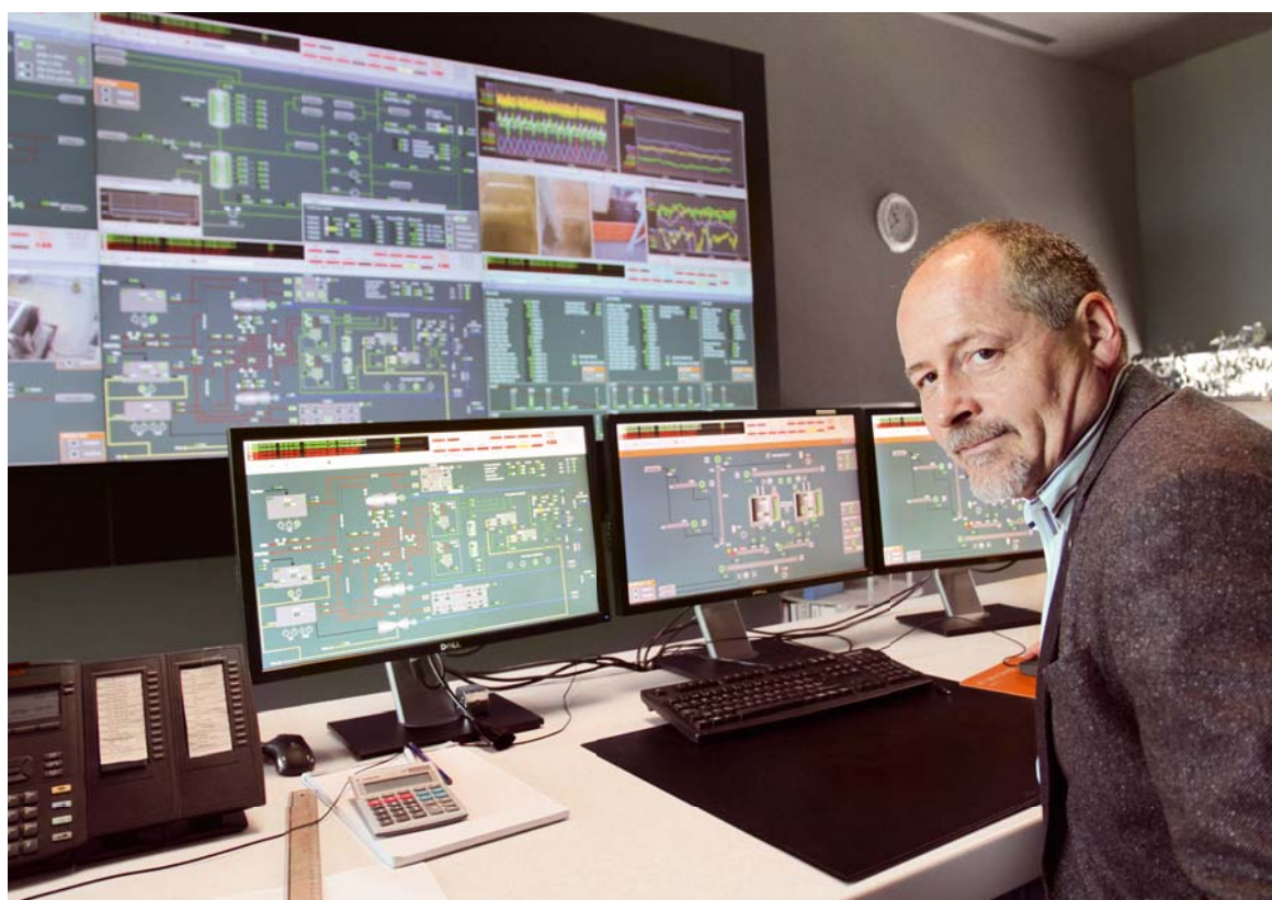
Roland Hediger dans la salle de commande de la centrale énergétique Forsthaus. L'usine de valorisation des déchets, la centrale de chauffage au bois et la centrale à cycle combiné gaz/vapeur y sont commandées centralement avec le système 800xA d'ABB.
