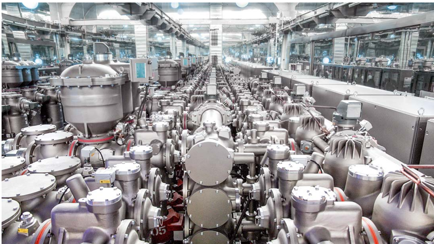
La nouvelle installation de distribution isolée au gaz éco-efficace à Oerlikon.
