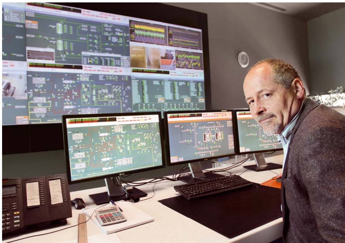
Roland Hediger im Kommandoraum der Energiezentrale Forsthaus. Hier werden die Kehrichtverwertungsanlage, das Holzheizkraftwerk sowie das Gas- und Dampfkombikraftwerk zentral mit dem Leitsystem 800xA von ABB gesteuert.
