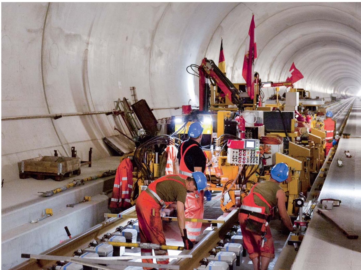
Die letzten Arbeiten im Gotthard-Basistunnel sind bald abgeschlossen. Der Countdown bis zur grossen Eröffnung läuft.
