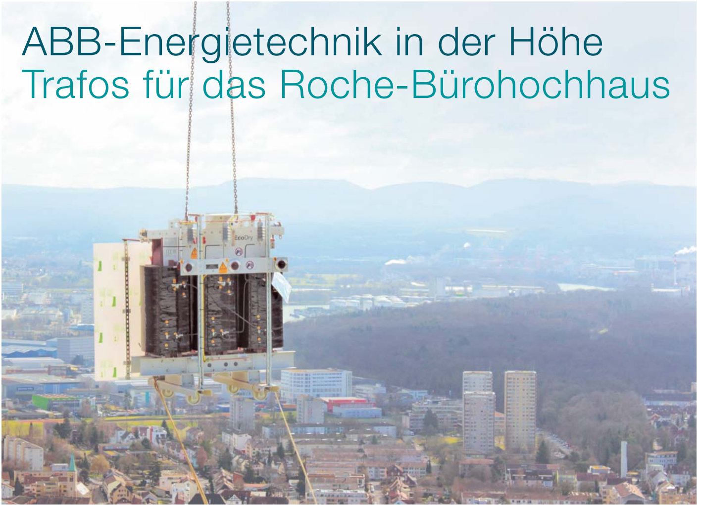
Anlieferung eines Transformators in Etage 41 des Roche Gebäudes Bau 1 vor dem Panorama Basels.
