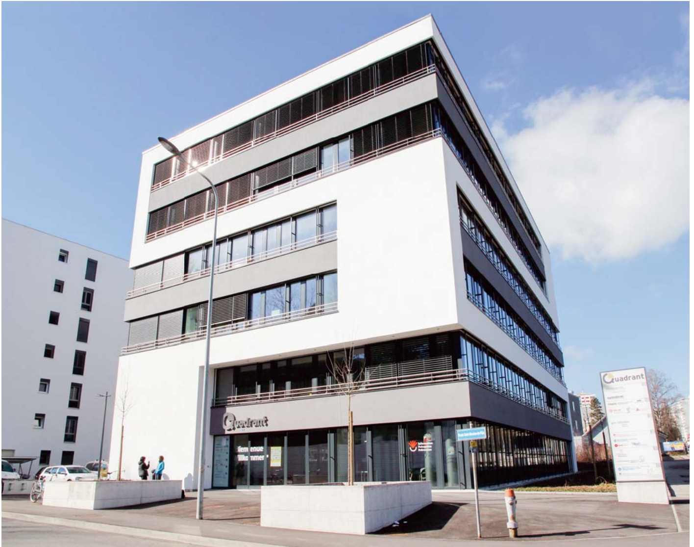
Une solution immotique éco-énergétique a été mise en œuvre dans le Quadrant à Fribourg avec des équipements KNX d'ABB.
