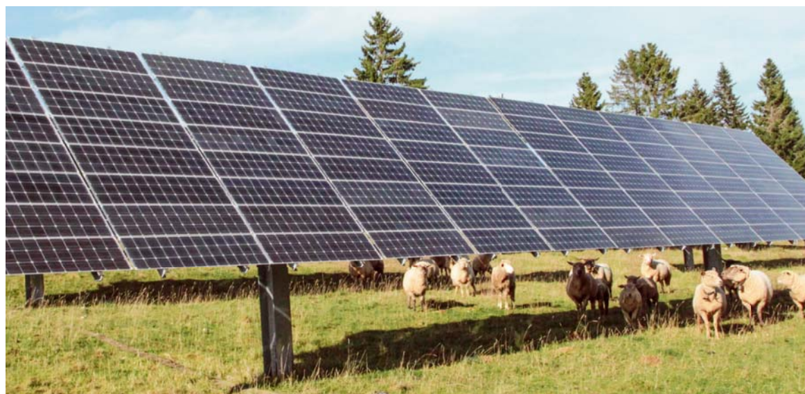
Am letzten Mai-Wochenende lädt das lauschig gelegene Solarkraftwerk auf dem Mont Soleil zu den Tagen der offenen Tür ein.
