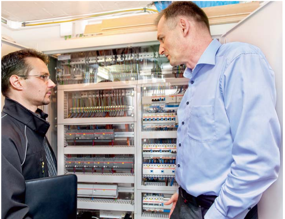
Elektroinstallateur Roger Acklin (l.) mit Dieter Kunert vor dem Schaltschrank im Keller.
