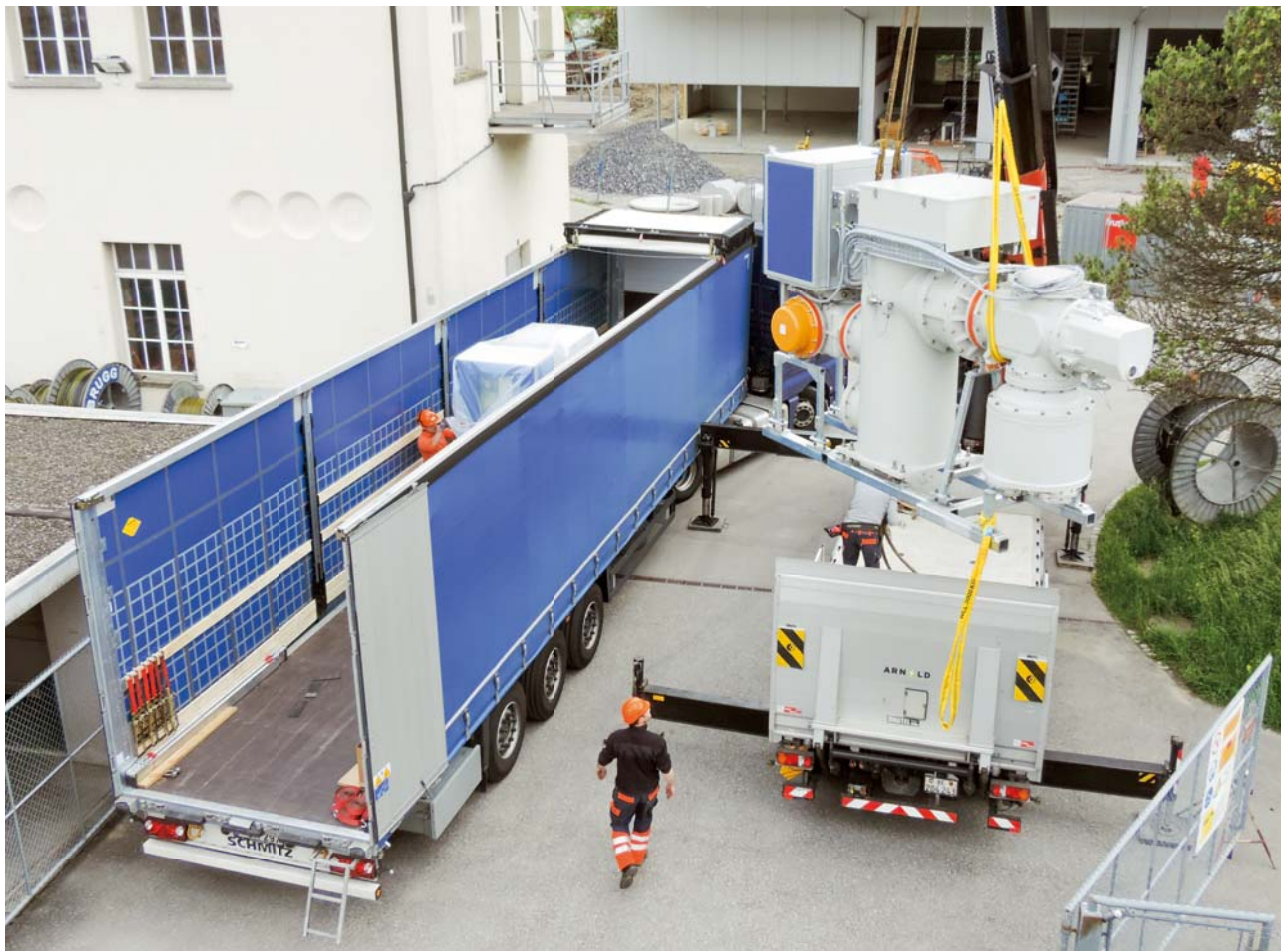
Umladen der GIS-Felder vor dem Transport ins Gebäude.
