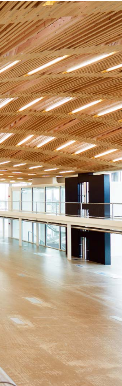
Das von Robotern gefertigte Holzdach des Arch_Tec_Lab.
